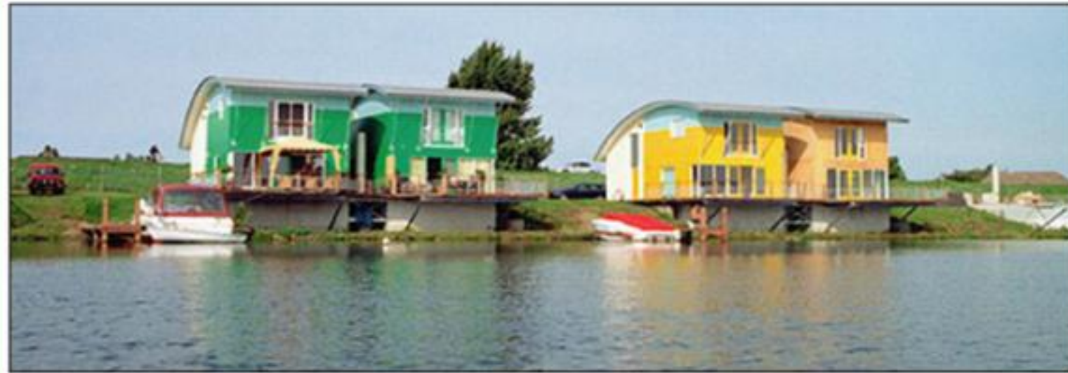
บ้านใน Maasbommel อยู่ห่างจาก Amsterdam ราว 60 ไมล์ สร้างด้วยโครงสร้างที่มีน้ำหนักเบาสามารถลอยน้ำได้
